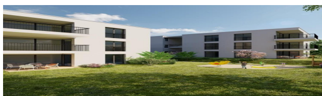
Façade sud — Immeuble 2
